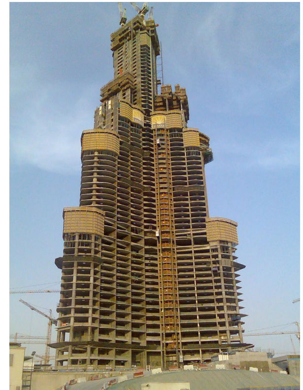
La plus grande tour de Dubaï (Ossature en béton armé)
