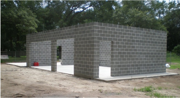
Construction en parpaing
