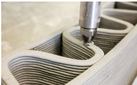
Construction par une imprimante 3d (avec du béton).
